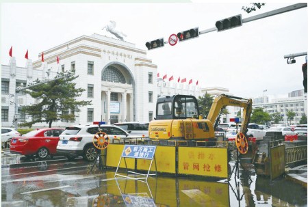
7 月 10 日，呼和浩特市供排水管网抢修工程。 贝赫 / 摄
