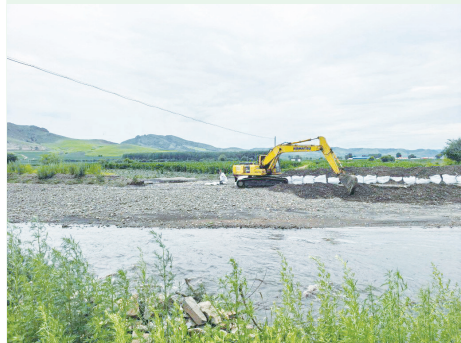
7 月 12 日，兴安盟科尔沁右翼前旗德伯斯镇正在修复被冲毁的山洪沟溃口。 恩浩 / 摄
